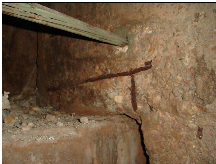
Figura 5.34 – exposição da armadura da longarina (galeria GB 41)
