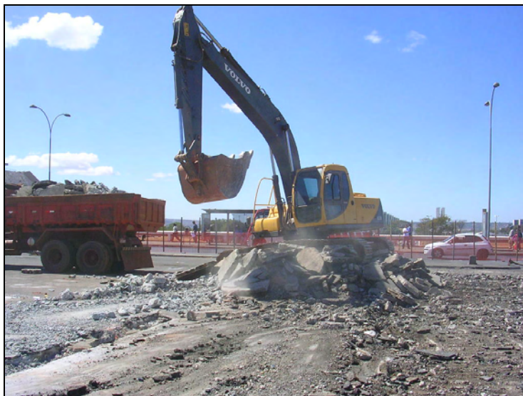
Figura 4.6 – Serviços de demolição do pavimento existente (Soltec Engenharia, 2007)
