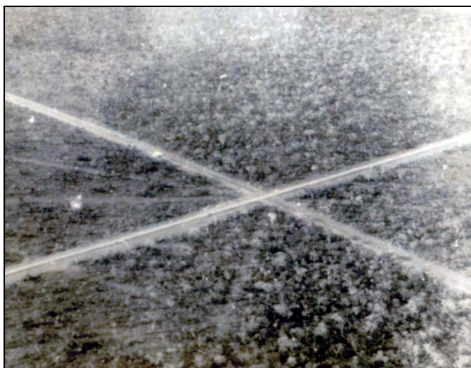
Figura 2.1 – Cruzamento dos Eixos Monumental e Rodoviário antes da construção da cidade de Brasília, 1956-1957 (Arquivo Público DF).
