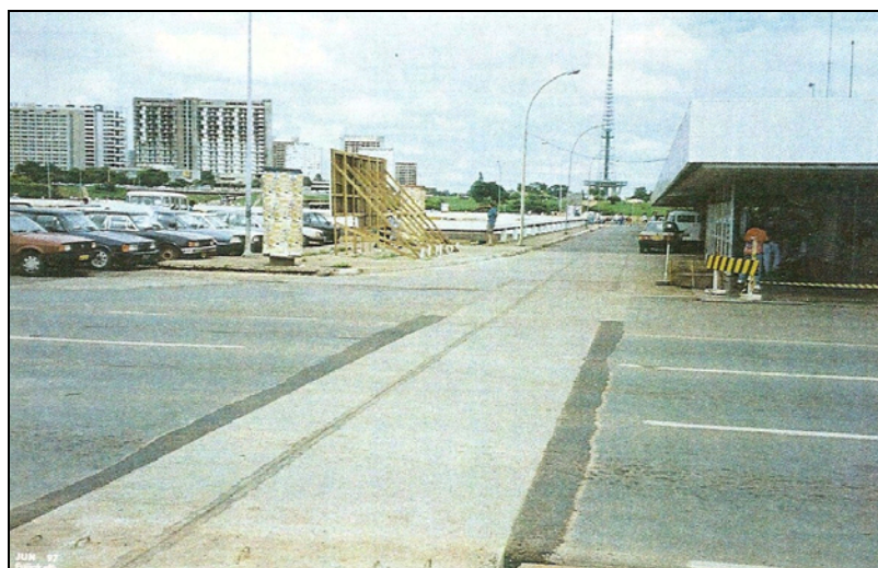
Figura 4.4 – Juntas de dilatação após a execução (Relatório de Assessoria UnB – 1997)
