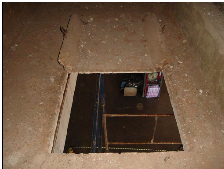
Figura 5. 2 – Tampa de concreto da janela de inspeção de uma galeria
