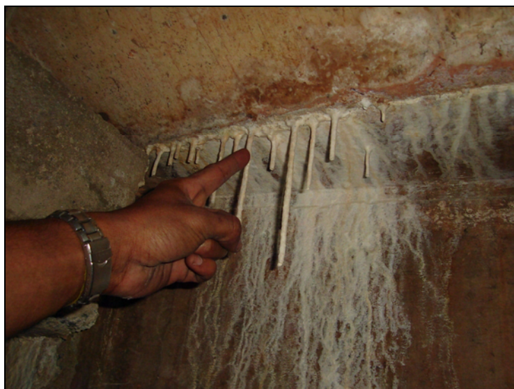
Figura 5.56 – Estalactites formadas por eflorescências bem desenvolvidas (galeria GA 63)
