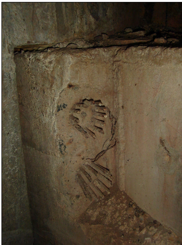
Figura 5.18 – Cones de ancoragem expostos (galeria GB 61)
