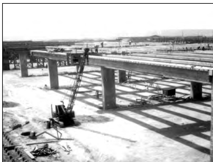
Figura 2.17 – Guindastes posicionando as longarinas sobre os quadros em 1959 (Arquivo Público, autor não identificado)
