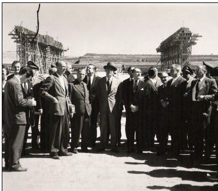
Figura 2.3 – Em 20 de junho de 1959, foi colocada no lugar a primeira viga pré-moldada. Autoridades presente ao ato (Arquivo Público DF).
