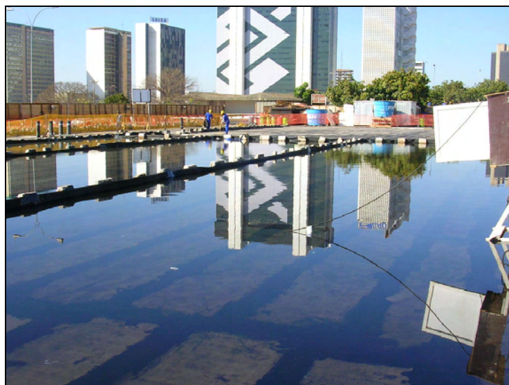
Figura 4.10 – Teste de estanqueidade da impermeabilização (Soltec Engenharia, 2007)
