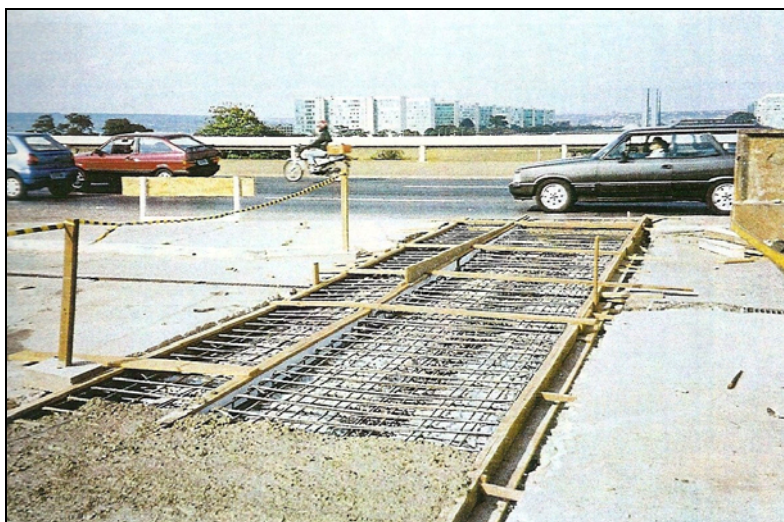
Figura 4.3 – Detalhe da execução da laje de solidarização (Relatório de Assessoria UnB – 1997)
