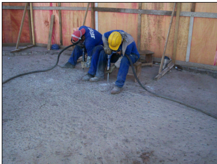
Figura 4.7 – Serviços de apicoamento da superfície do concreto da laje da plataforma (Soltec Engenharia, 2007)
