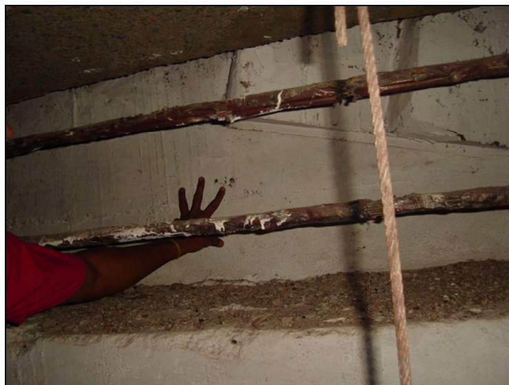
Figura 5. 7 – Viga “T” invertido em boas condições (galeria GB 75)
