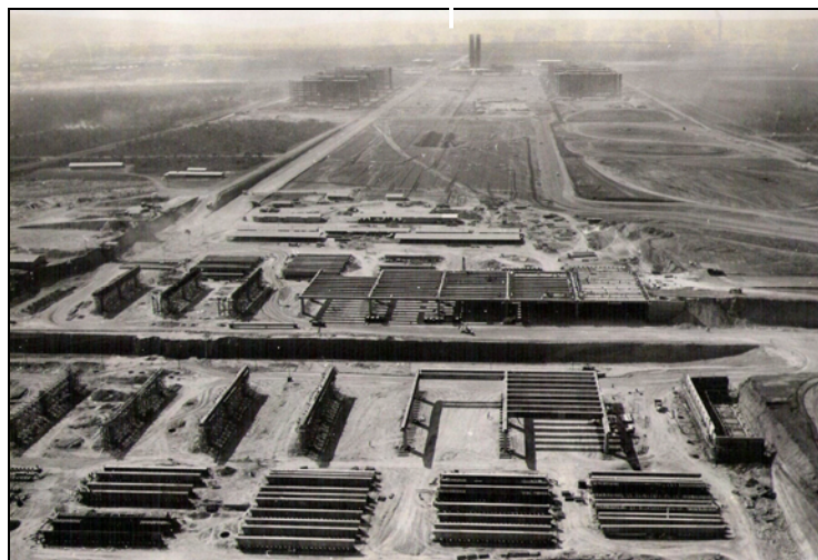
Figura 2.4 – Em 20 de agosto de 1959, parte do vigamento estava concluída e iniciada a primeira laje. No primeiro plano, vigas pré-moldadas prontas e em execução, nos estaleiros. No canto inferior direito da figura, o caminhão, próximo às armações do muro de encontro, dá idéia da magnitude da obra. (Arquivo Público DF).
