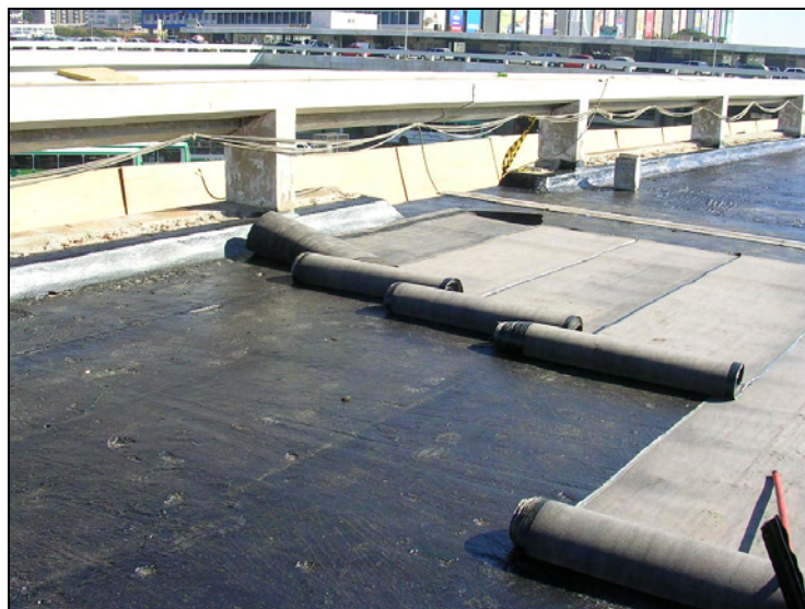
Figura 4.9 – Serviços de colocação de mantas asfálticas de impermeabilização (Soltec Engenharia, 2007)
