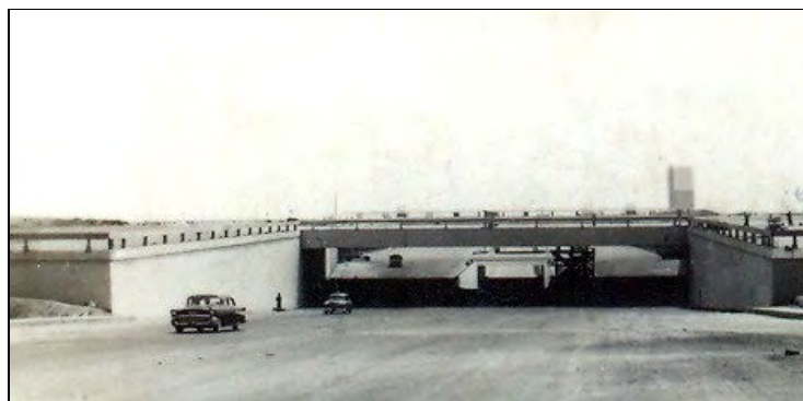
Figura 2.7 – Eixo Rodoviário norte sul em novembro de 1960, com a passagem inferior ao centro, (Arquivo Público DF).
