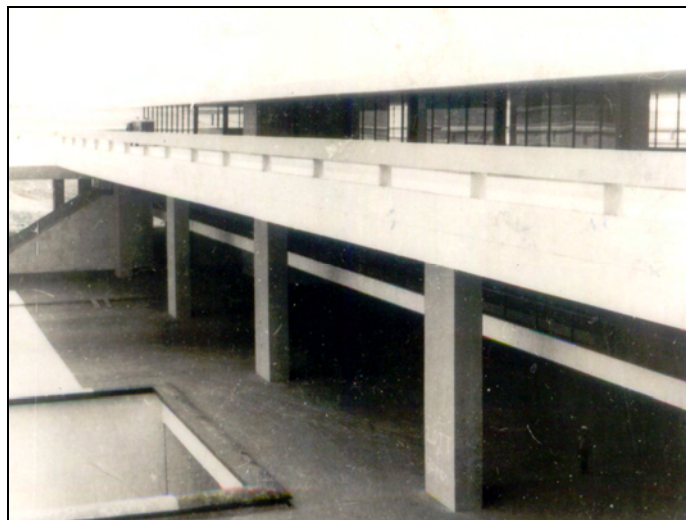
Figura 2.24 – Estrutura do Mezanino e da Cobertura (Arquivo Público DF, autor e data não identificados).
