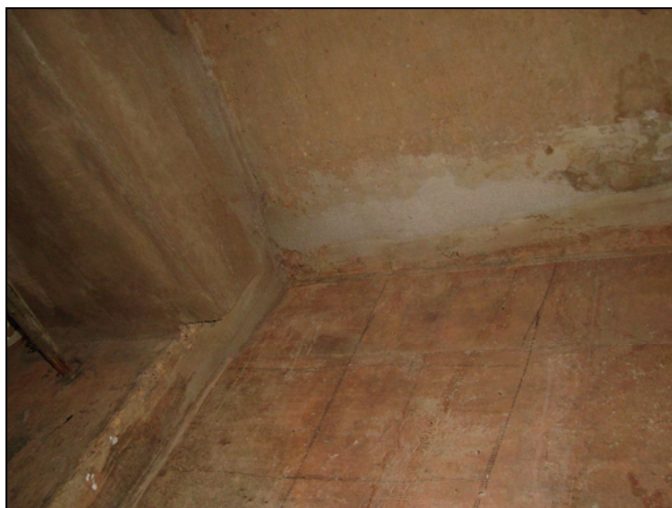
Figura 5.39 – Ausência de sinais de infiltração devido a reparos (galeria GB 17)
