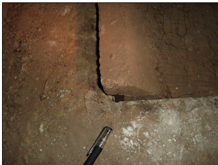
Figura 5. 3 – Detalhe da borda lateral da tampa de concreto mostrada na figura 5. 1
