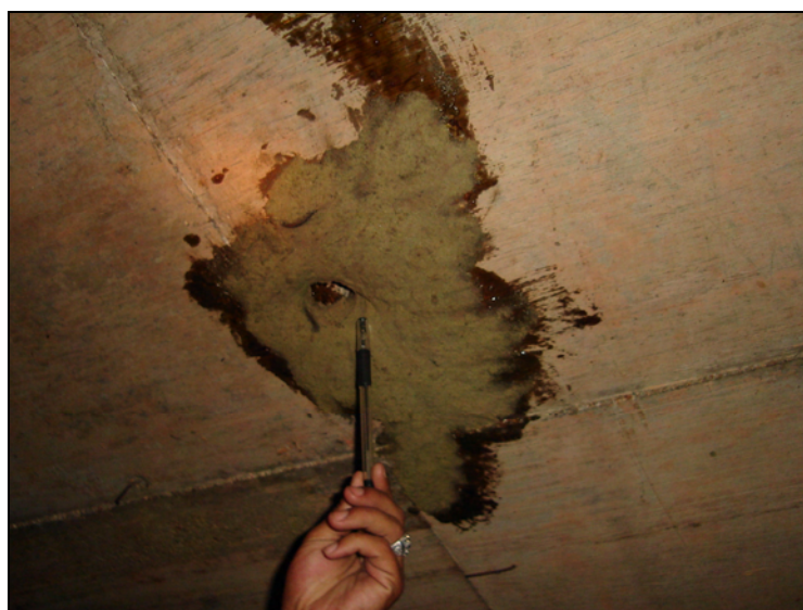
Figura 5.10 – Intervenção antiga na laje superior em boas condições (galeria GB 86)
