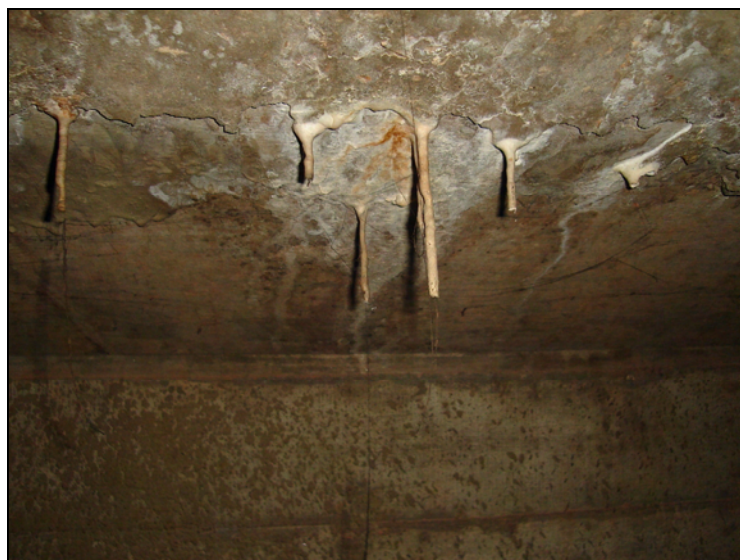
Figura 5.29 – eflorescência com formação de estalactites na junção de um reparo antigo (galeria GB 38)
