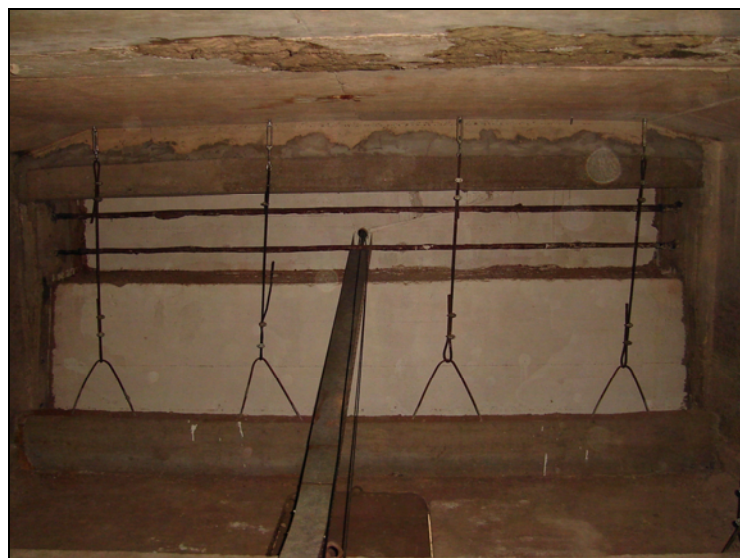
Figura 5.67 – VT em bom estado de conservação na galeria GA 57
