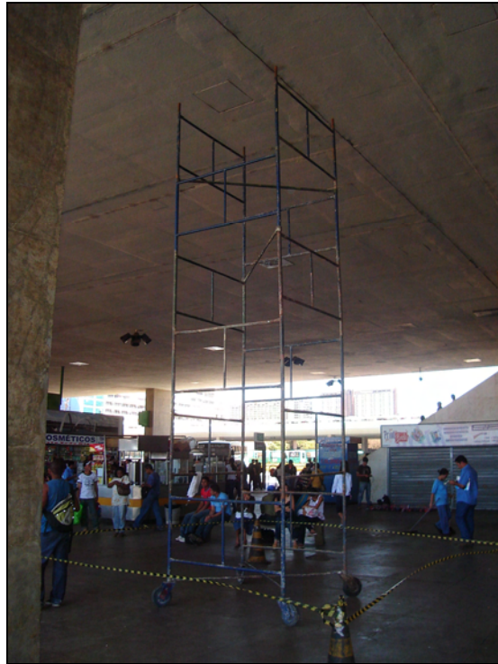
Figura 5. 1 – Andaime utilizado para a visita às galerias
