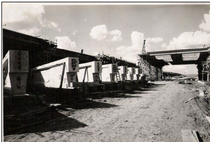
Figura 2.6 – Canteiro de obra em 10 de novembro de 1959 (Arquivo Público DF).
