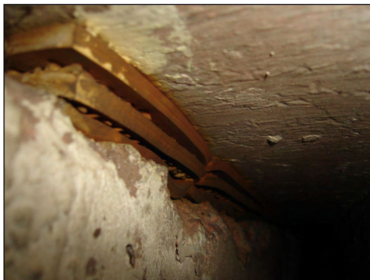
Figura 5.11 – Aparelho de apoio condições aparentemente satisfatórias (galeria GB 86)
