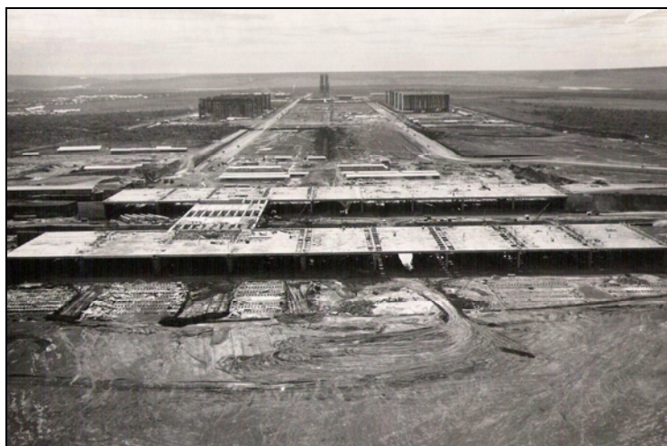
Figura 2.8 – “H” principal da estrutura da Plataforma Superior da Estação Rodoviária de Brasília, 1957-1960 (Arquivo Público DF, autor não identificado).
