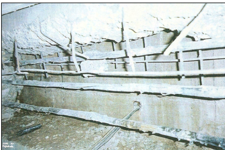
Figura 4.5 – Detalhe da remoção do concreto da parte inferior da VS (Relatório de Assessoria UnB – 1997)
