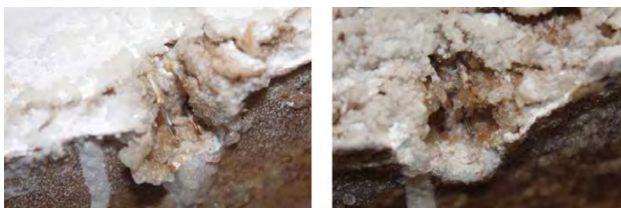
Figura I.14 – Corrosão dos sensores de aço inox no ciclo de exposição final
