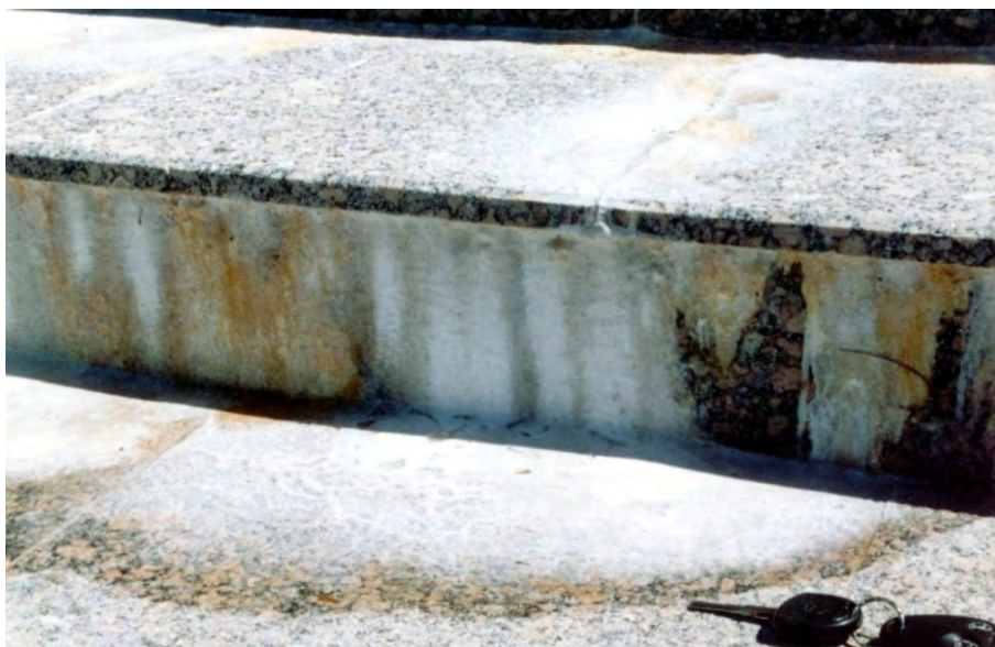
Figura 2.14 – Eflorescência em revestimento de granito na escada de edifício público
