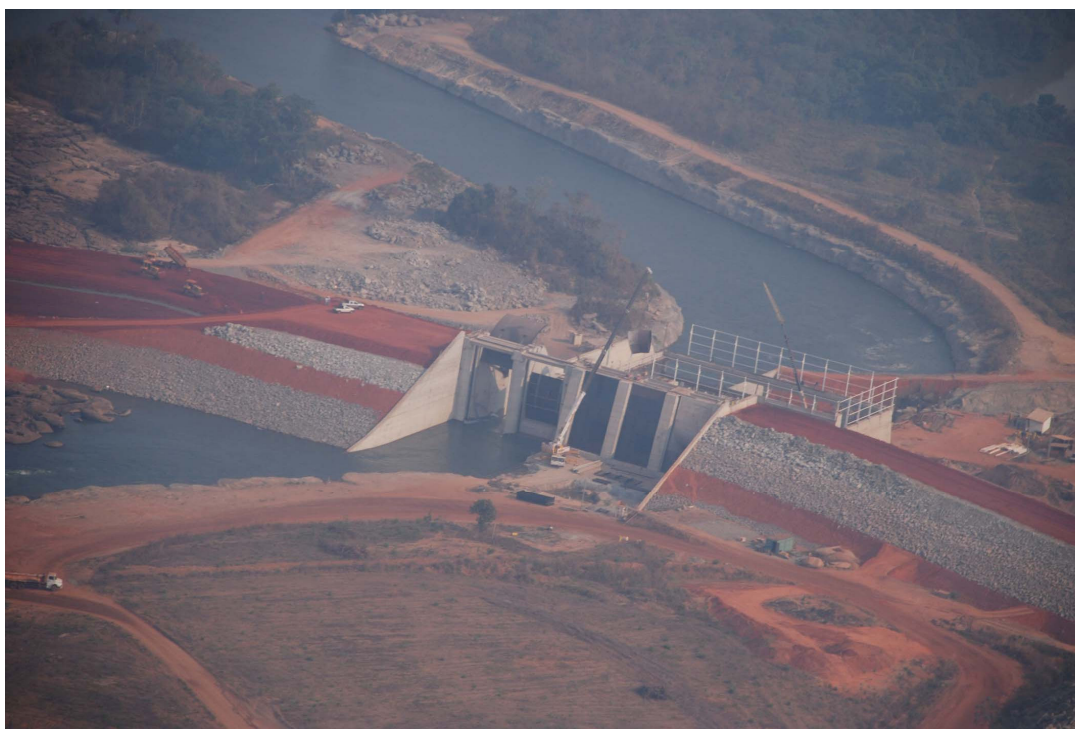
Pequena Central Hidrelétrica – PCH Paranatinga II em fase final de construção em 2008. Foto cedida pela ACT.
