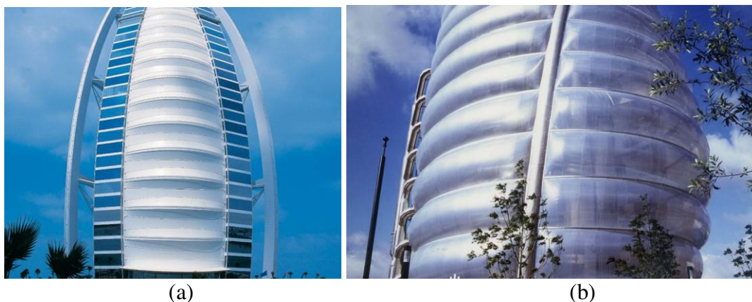
Figura 2.4: Uso das estruturas de membrana como elemento de fachada 1 : (a) em Dubai, Emirados Árabes; (b) em Leicester, no Reino Unido.
