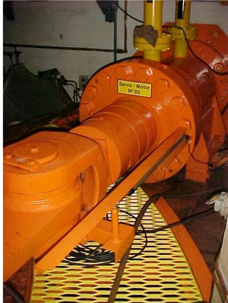
**Figura 1-2 - Servo motor hidráulico de acionamento do anel distribuidor**
