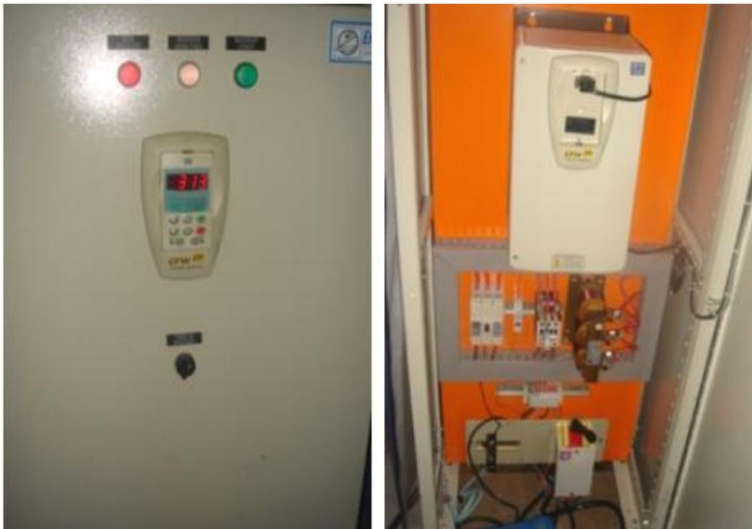
Figura I-1 – Inversor de frequência
