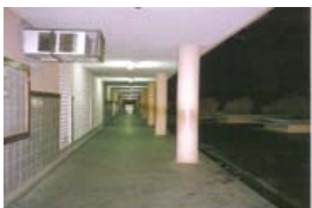
Corredor de Acesso às Salas de Aula
