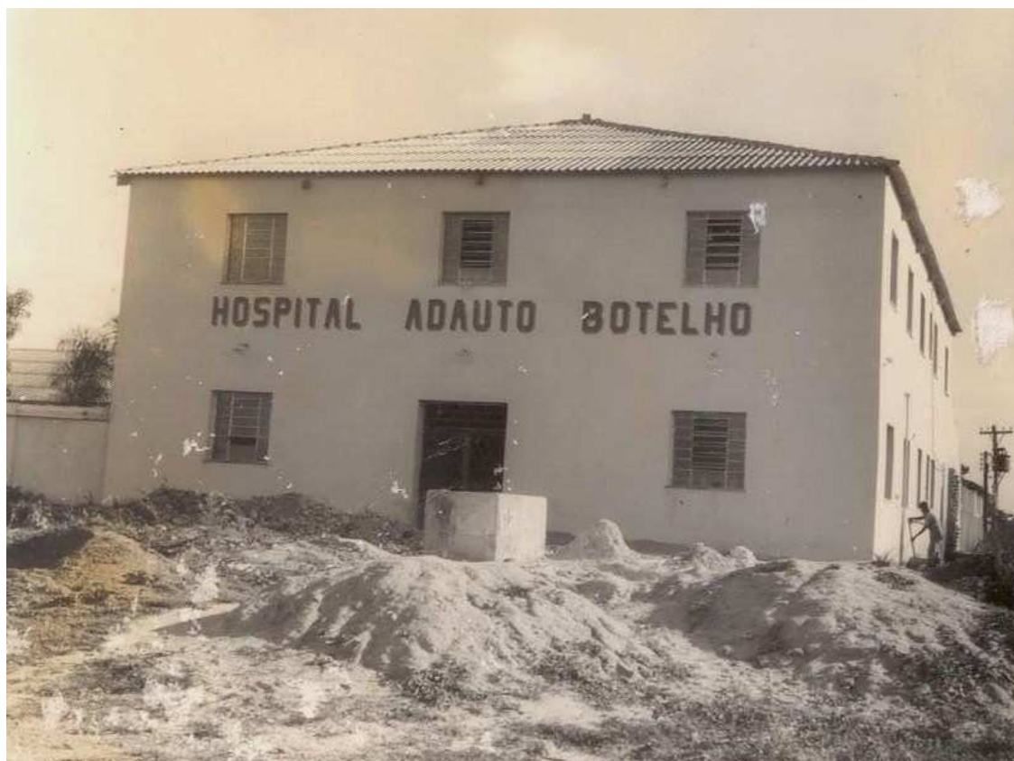
Foto 46 – Obras da parte externa da instituição Adauto Botelho 70 .
