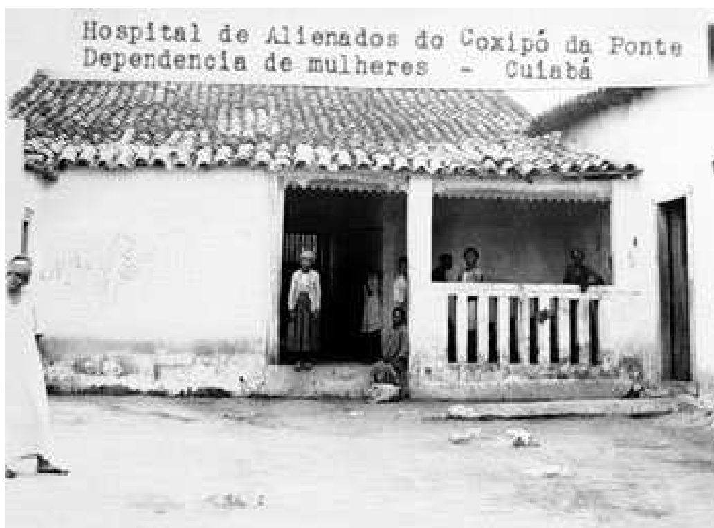
Foto 30 – Dependência de Mulheres do Hospital de Alienados do Coxipó da Ponte, Cuiabá. Fonte: INSTITUTO PHILIPPE PINEL, 2010
