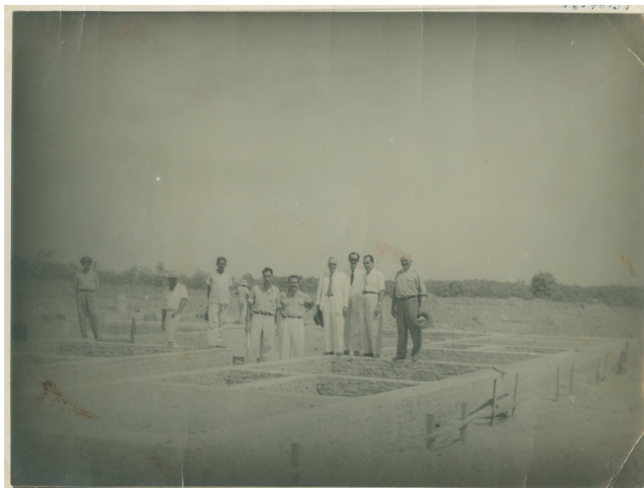
Foto 34 – Visita do Coordenador Nacional de Saúde Mental, Dr. Aduino Botelho, às obras de edificação do novo Hospital de Alienados de Cuiabá.
