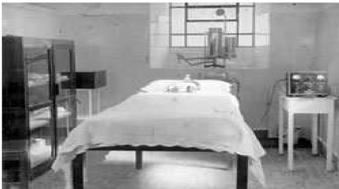
Foto 37 – Dependência para eletrochoque. Fonte: INSTITUTO PHILIPPE PINEL, 2010.
