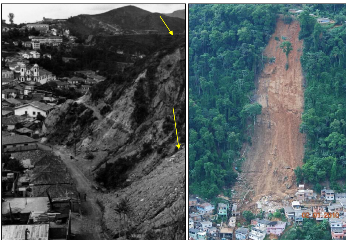
Figuras 03 e 04: Escorregamento no bairro Antônio Dias, na área tombada de Ouro Preto, na década de 1970, e deslizamento ocorrido em Angra dos Reis (RJ), na passagem do ano de 2009 para 2010. Fonte: Respectivamente, Imagem do IPHAN/Ouro Preto 5 e Vieira (2010).
