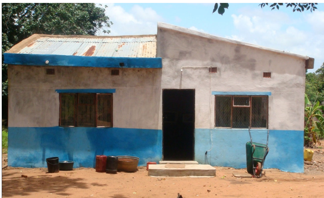
Foto 05: exemplo de uma habitação de dois cômodos do SP2 Fonte: Autora
