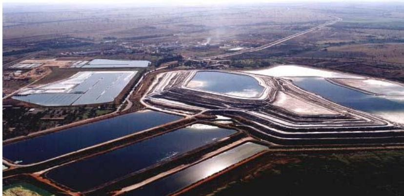
Figura 2.8 - Disposição do fosfogeno pela deposição a úmido (Canut, 1996).
