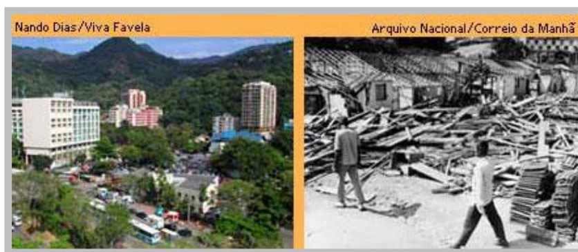
Figura 15: Atual situação do terreno onde foi executado o Parque Proletariado nº1 (PUC – RJ) e a derrubada das casas na década de 50.
