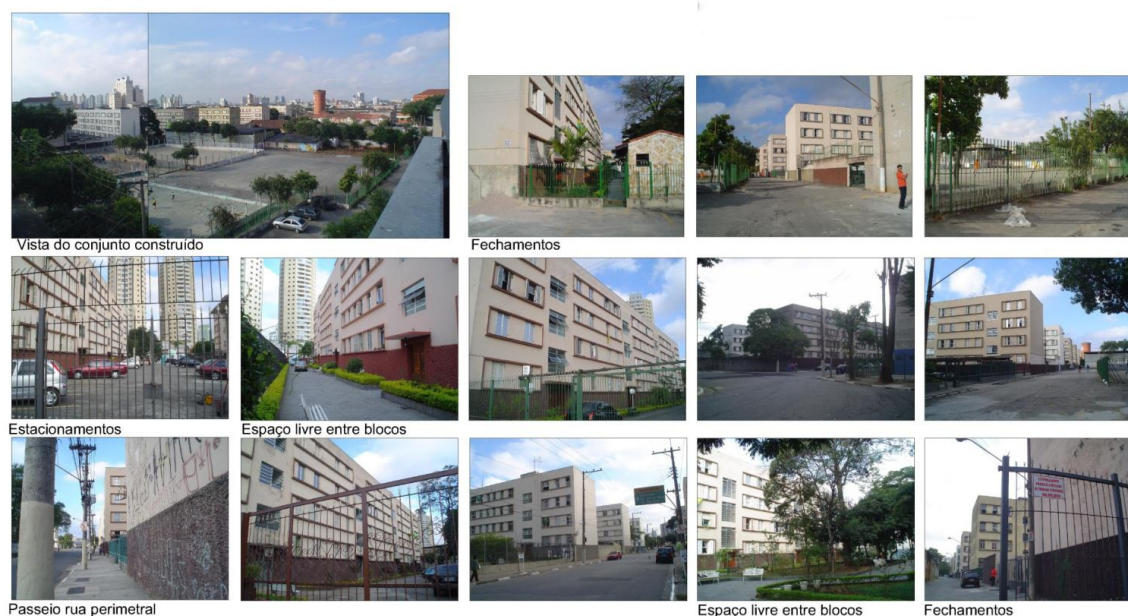
Figura 13: Fotos da atual situação do Conjunto Várzea do Carmo.
