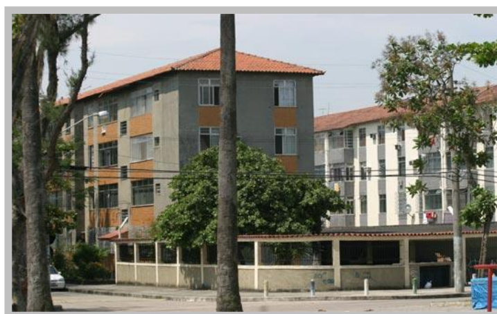
Figura 14: Conjunto Residencial da Penha, projeto IAPI.
