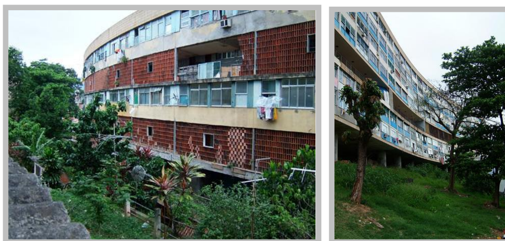
Figura 27: Conjunto Residencial Prefeito Mendes de Moraes, Pedregulho, condições de abandono e descaracterização na atualidade.
