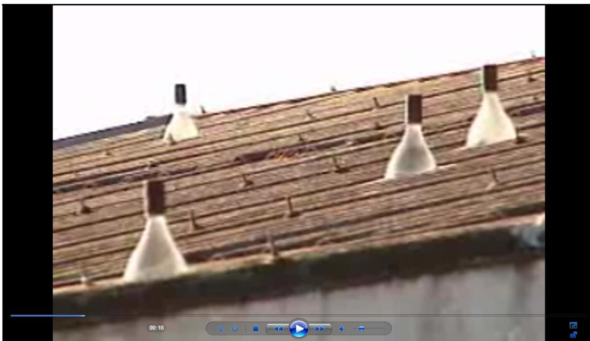
Figura 2.5 - Sistema de aproveitamento de iluminação natural com sistema de garrafa PET<sup>7</sup>.
