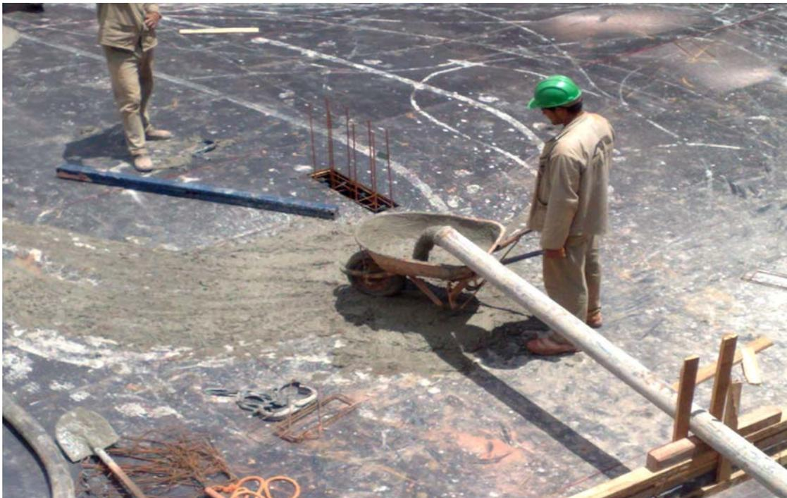
Foto 4.5 - Desperdício de concreto durante a Concretagem, Empresa B. Fonte: acervo pessoal do autor (2008).
