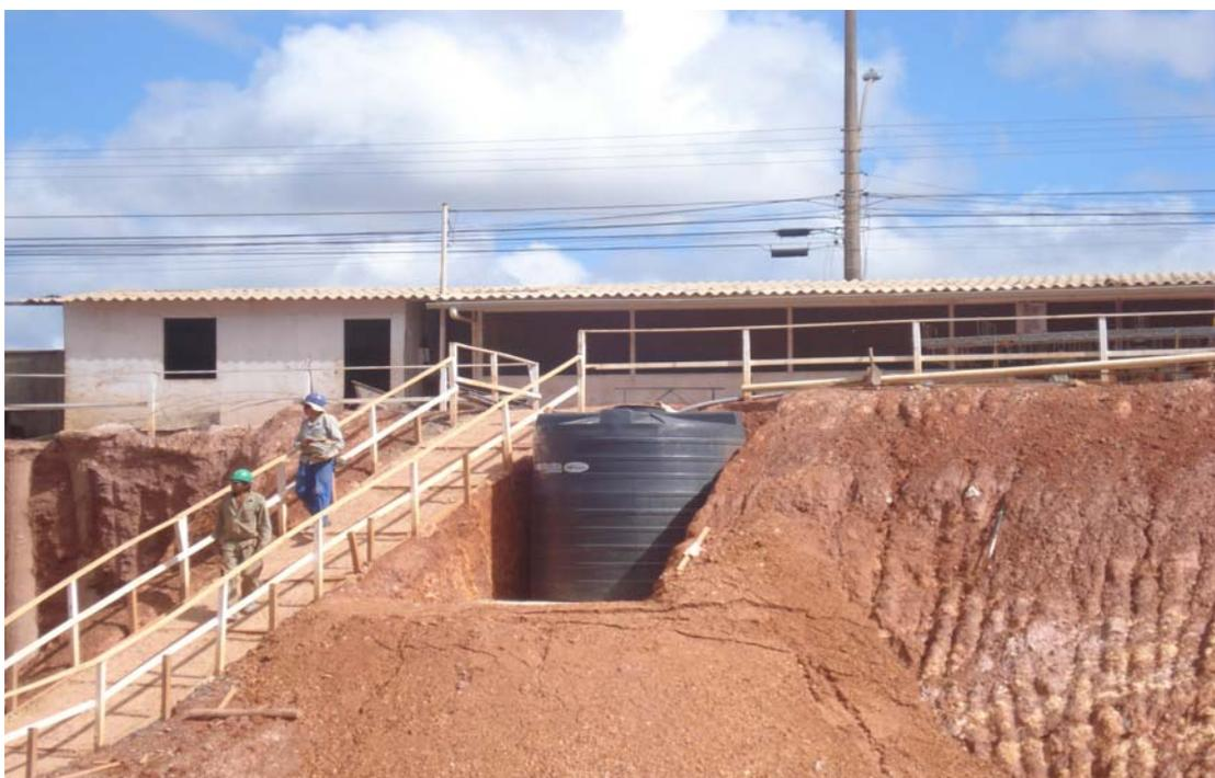
Foto 4.8 – Reservatório de captação de águas pluviais, Empresa A. Fonte: acervo pessoal do autor (2008).
