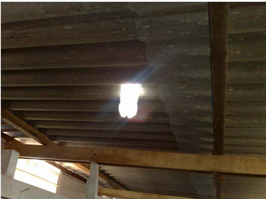
Foto 4.9: Aplicação do sistema de iluminação natural por uso de garrafas PET no canteiro, Empresa D. (Fonte: Autor 2008).
