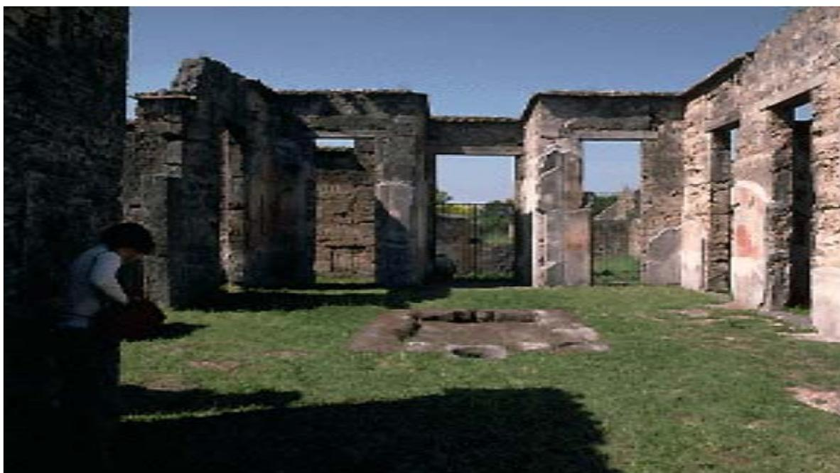
Figura 2.6 - Reservatório de água pluvial no atrium de uma casa, em Pompéia, antes da construção do aqueduto da cidade no final do 1o séc. A.C.
