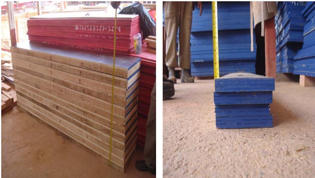
Foto 4.1 – Execução dos Painéis das fôrmas de madeira (Empresa B) – Fonte: acervo pessoal do autor (2008).
