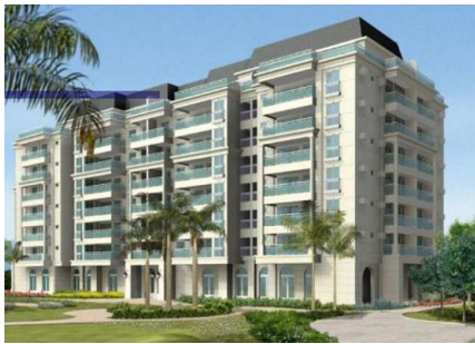
Figura 22: Edifício com proteção vertical, formada pelo recuo da fachada.
