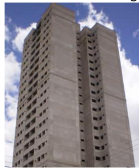
Figura 23: Edifício com proteção vertical, formada pelo recuo da fachada.
