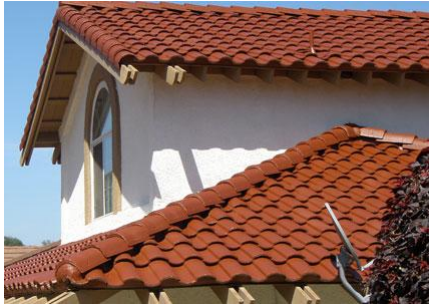
Figura 20: Edificação residencial com beiral
