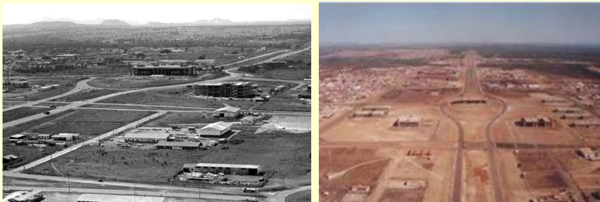
Figuras 246 e 247- Fotos da área central de Palmas, a Praça dos Girassóis e as principais edificações do poder estadual ao centro – Palácio do Governo, Assembleia Legislativa e Tribunal de Justiça – em construção (1993). Fontes: SECOM, 2011 (Crédito do Fotógrafo Márcio Di Pietro) e SEMUC, 2006.
