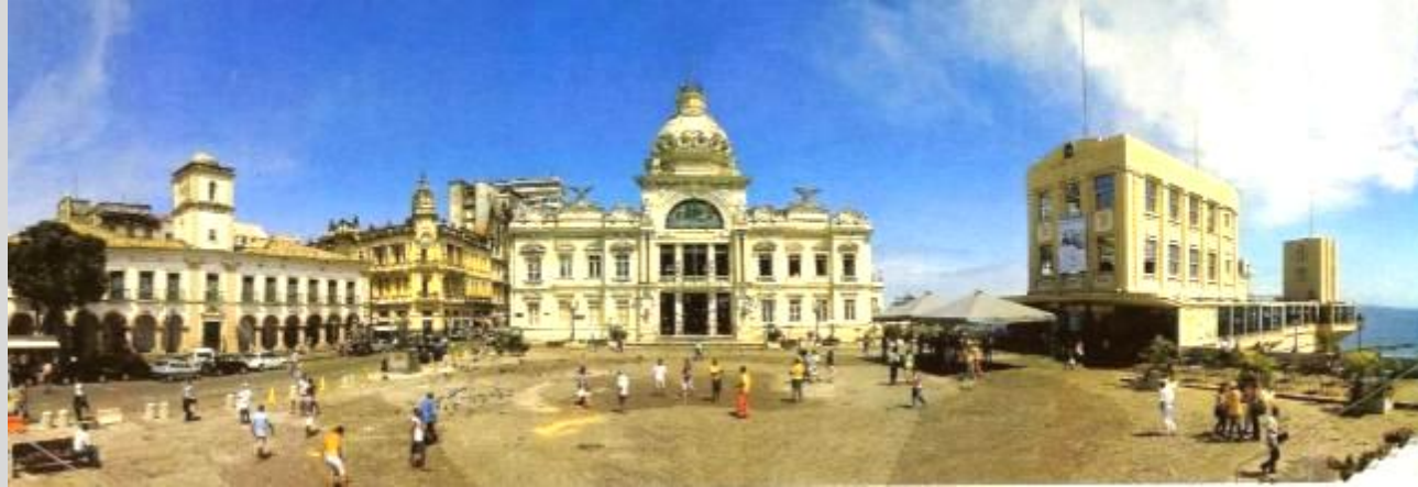
Figura 7-Praça Municipal de Salvador. Para SITTE (1980, apud CHOAY, 1998), “cada cidade, por menor que fosse, poderia orgulhar-se de uma praça bela e original, se todos os edifícios importantes estivessem ali reunidos como numa exposição em que um valorizasse o outro”. Nesta foto: Câmara dos vereadores, Palácio Rio Branco e Elevador Lacerda. Fonte: http://picasaweb.google.com/lusitanameister/ESTBahiaBR#5169750720899432338
