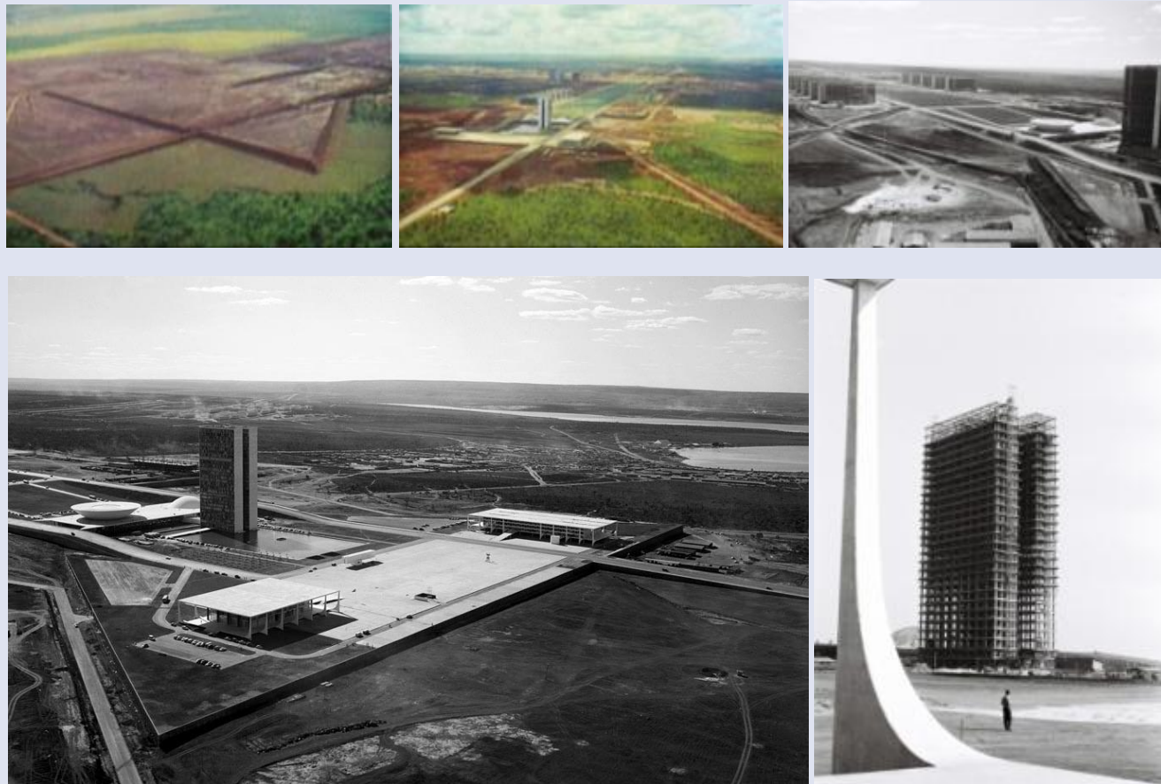
Figuras 183 e 184- O terrapleno da Praça dos Três Poderes. Fonte: MONTE JUCÁ, 2005, p. 117. Figura 185- A construção da Esplanada dos Ministérios e da praça. Fonte: Arquivo Público NOVACAP. Figura 186- A Praça dos Três Poderes construída. Fonte: Arquivo Público NOVACAP. Figura 187- A construção das torres do anexo do Congresso. Fonte: Arquivo Público NOVACAP.
