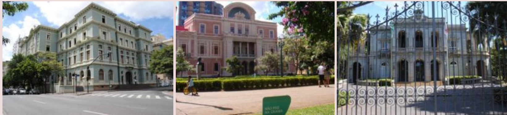
Figura 57- Antiga Secretaria de Viação e Obras Públicas, que ainda abriga a sede do IEPHA/MG. Figura 58- Intervenção de Paulo Mendes da Rocha na antiga Secretaria da Educação, atual Museu das Minas e do Metal. Figura 59- Palácio da Liberdade – portões fechados durante a semana. Crédito: Ludmila Dias.
