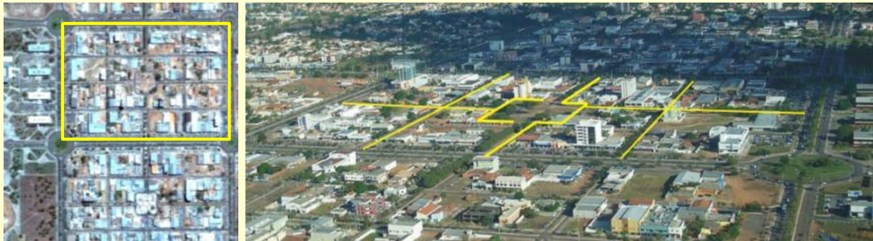
Figura 243- Vista de uma quadra comercial no entorno da Praça dos Girassóis, no quadrante nordeste. Estão em destaque as vias que foram projetadas como vias de pedestre, mas não funcionam como tal e a praça no interior da quadra. Fonte: Google Earth e http://static.panoramil.com/photos/original/1410703.jpg
