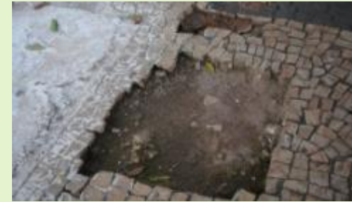
Figura 152- Pavimento deteriorado.
